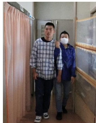
↑ 車いすで離合ができない狭い廊下
